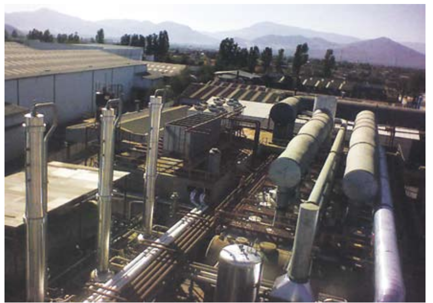
Vista aérea de la nueva Planta de Recuperación de Solventes de Edelpa.
